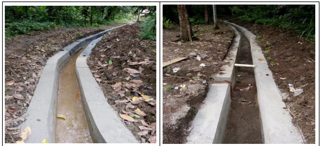
Gambar 3.8 Kegiatan Rehabilitasi Irigasi Tersier
