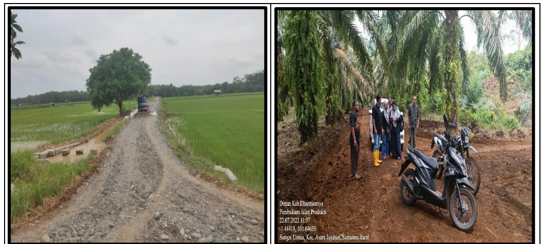
Gambar 3.9 Kegiatan Pembanguna/Rehabilitasi Jalan Usaha Tani dan Jalan Produksi
